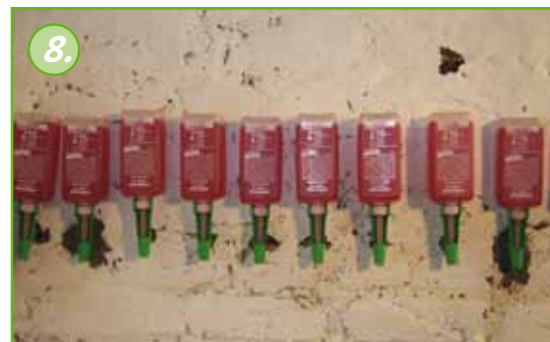
Впрыскивание KÖSTER Crisin® 76 без давления начинается с установки картриджей.
