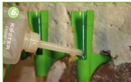
Резервуары всасывающих угловых шлангов KÖSTER заполняются водой для предварительного замачивания капиллярных стержней KÖSTER, чтобы они набухли.
