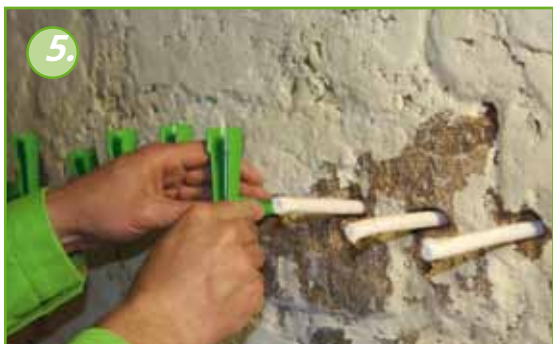
Углы всасывания KÖSTER используются таким образом, что капиллярные стержни KÖSTER достигают своего резервуара.
