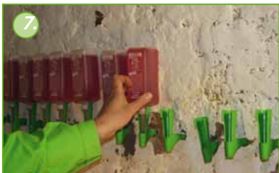
Картриджи KÖSTER Crisin® 76 устанавливаются на всасывающие патрубки KÖSTER.
