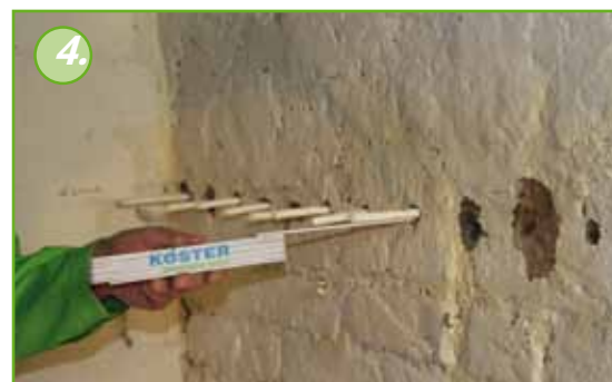
Капиллярные стержни KÖSTER устанавливаются таким образом, что их концы выступают из стены на 7 см.
