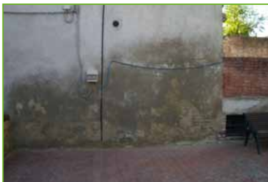
Изменение цвета, снижение теплоизоляции.
