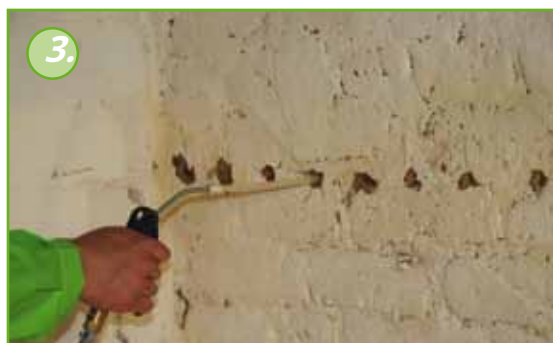
Скважины очищаются путем удаления буровой пыли с помощью сжатого воздуха.
