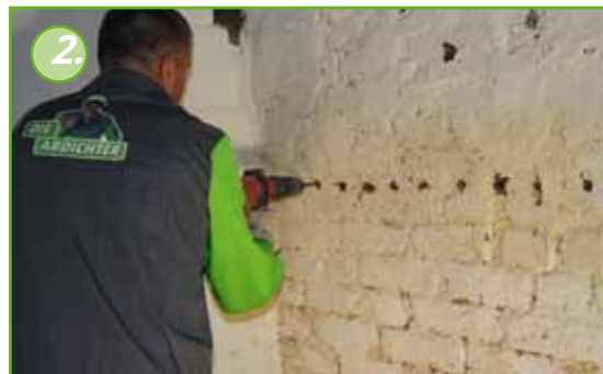
Внутреннюю стенку сверлят с интервалом 10 см на глубину 40 см (толщина стенки 45 см).
